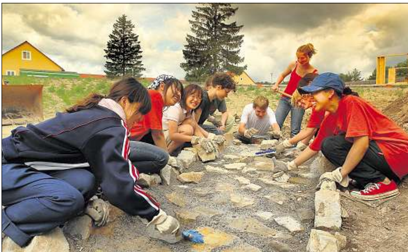
„We build a river“, erzählten die junge Damen gestern Vormittag beinahe im Chor. Es wird zwar kein richtiger Fluss, aber Wasser wird ihr Bauwerk schon bald führen. Elf junge Frauen aus Japan, Frankreich, Polen, Italien, Malaysia und Deutschland beteiligen sich derzeit auf dem Gelände der Jugendherberge Harsberg an einem dreiwöchigen Workcamp, den die Internationalen Jugendgemeinschaftsdienste (ijgd) organisierten. „Das Regenwasser aus der Dachentwässerung der Jugendherberge soll in ein Auffangbecken fließen und von dort über die neue 'Wasserstraße' in einen tiefergelegenen Teich“, erläuterte Kaszka Schwarzenberg den Sinn der Arbeiten am Harsberg. Damit das Regenwasser nicht zu schnell in den Teich stürzt, erhält der künstliche Bachlauf Hindernisse aus Kalkstein. In der Freizeit besuchten die fleißigen Damen Eisenach und Weimar. Am Wochenende geht es zum Baumkronenpfad. Foto: Meißner
