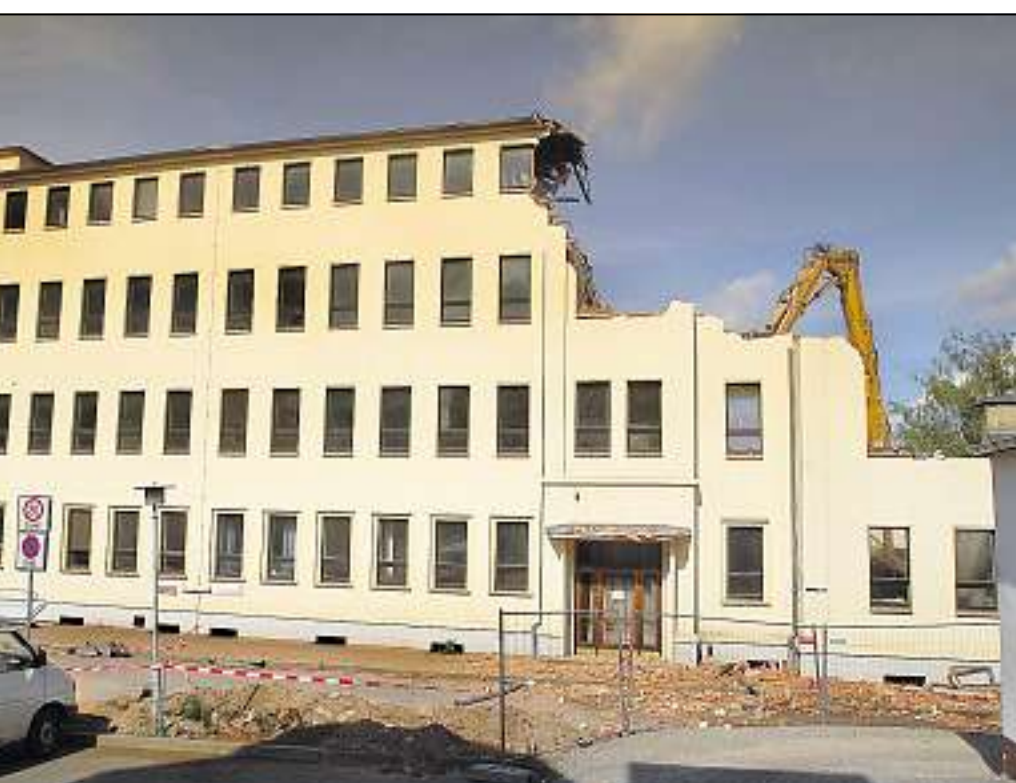
„Knusper, knusper, Knäuschen, wer knuspert an meinem Häuschen?“ Hänsel und Gretel waren es jedenfalls nicht. Die alte Frauenklinik des Kreiskrankenhauses Eisenach, in der sich vor dem Umbau im Jahr 1964 das Haftkrankenhaus befand, wird derzeit abgebrochen. Bevor die Abrissbagger anrollten, wurde das Mobiliar gesichert. Die Büromöbel und Betten gingen an verschiedene soziale Einrichtungen und an das Sozialkaufhaus, so Kliniksprecher Rainer Klive. Foto: Meißner
