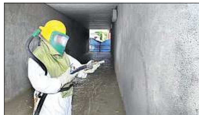
Thomas Witzmann wurde es gestern unter seiner Maske ganz schön heiß – dafür wurden die Wände schön sauber. Der Mitarbeiter der Stadtbeleuchtung befreite mit dem Sandstrahlgerät im Fußgängertunnel unter dem Bahndamm zwischen Rennbahn und Karl-Marx-Straße Eisenach die Wände von Graffiti-schmierereien. 5000 Euro gab die Stadt für das Gerät aus. Foto: Meißner
