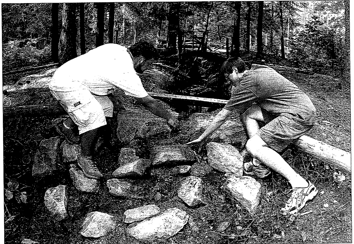
Die Deutsch-Studenten Thomas und Andrew (beide 19) aus den USA bauen beim Workcamp am Teich im Schulwald einen Damm. Er soll verhindern, dass Schlamm und Sand in den Teich gelangt und dieser zuwächst. Foto: Reichwein
